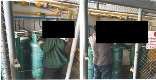
การฝึกซ้อมสถานการณ์การเกิดเหตุฉุกเฉิน กรณีแก๊สLPGรั่วไหลประจำปี2568 ผู้คุมจุดแผนกผลิตตรวจสอบว่าแก๊สรั่ว ซึ่งทำการโทรแจ้งไปยังแผนกช่างซ่อมบำรุง พร้อมเข้าดอปได้แก๊สฉุกเฉินและทำการปิดวาล์ว
